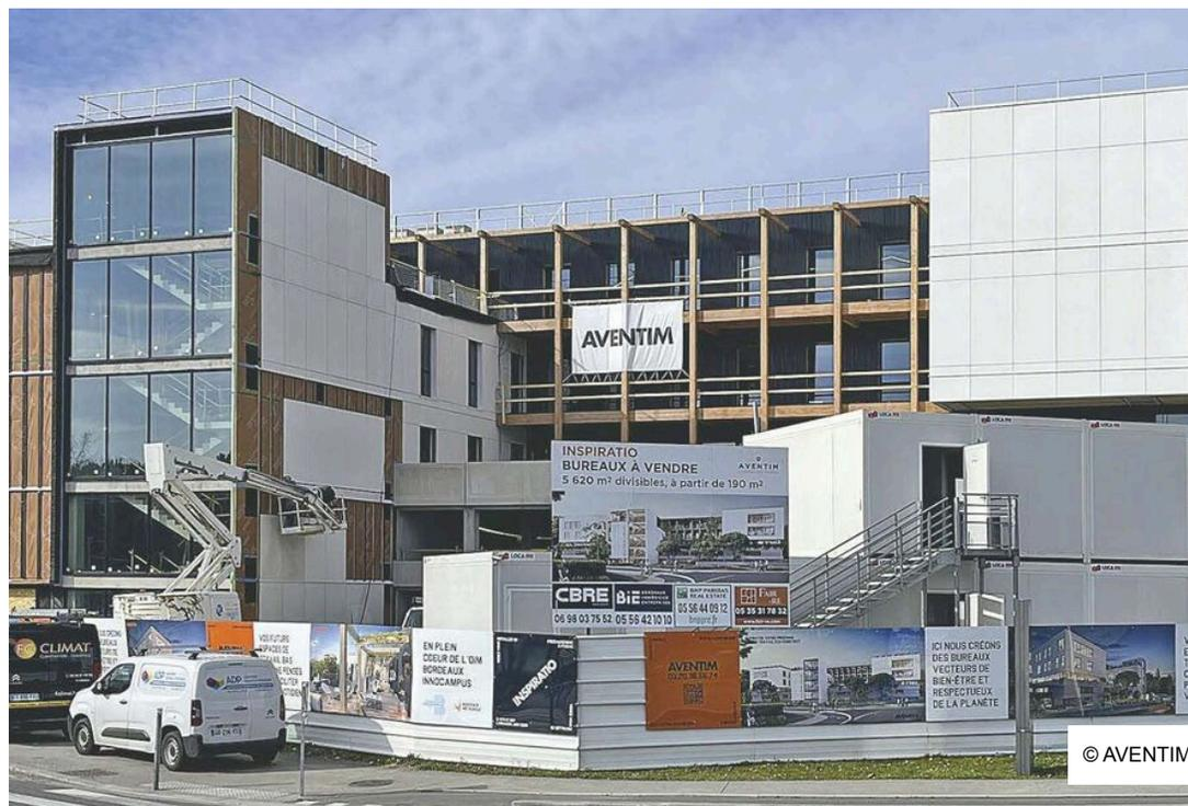
Le bâtiment, livré en juin, est doté d'une structure béton bas carbone intégrant des granulats recyclés et des façades en ossature bois.
