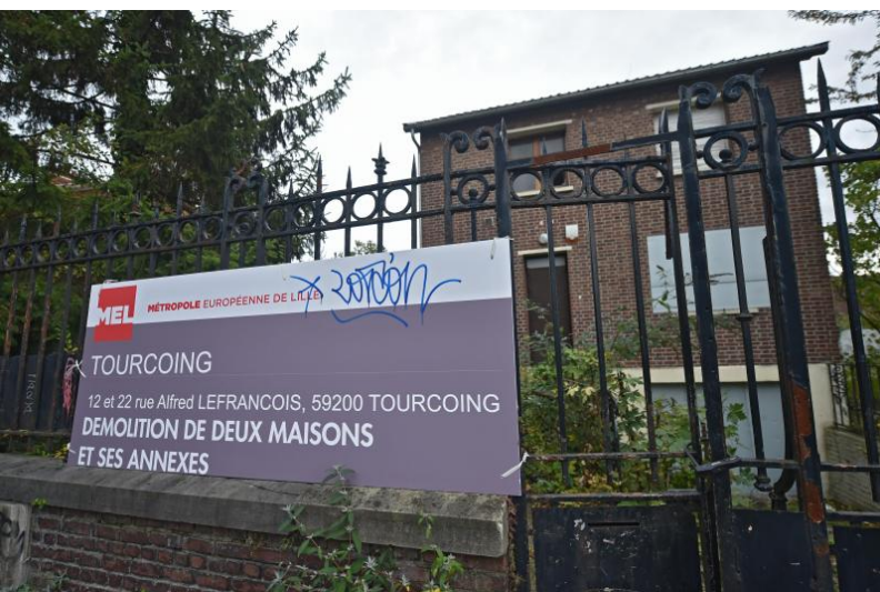
Les deux anciens pavillons de la SNCF doivent être démolis début 2020. PHOTO LA VOIX DU NORD / FRANCOIS FLOURENS - VDN
